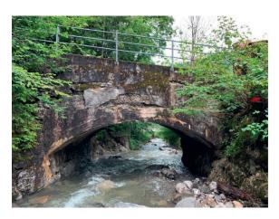
Die Brücke über den Leistbach soll neu gebaut werden. Geplant ist eine schiefwinklige Platte, die auf zwei 50 Zentimeter starken Widerlagerscheiben gelagert ist. Diese Widerlagerscheiben sind auf Mikropfählen fundiert. Die Spannweite der neuen Brücke beträgt rund 9.30 Meter.
