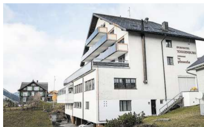
Im Oktober wurde auf der Rückseite des Hotels eine Photovoltaikanlage in Betrieb genommen.
