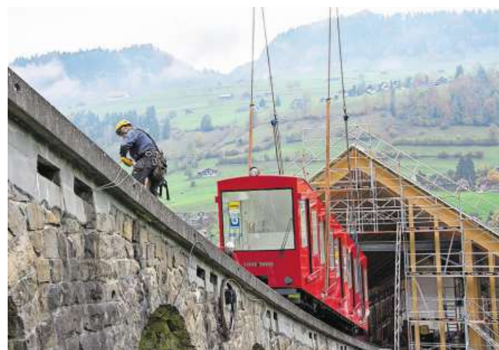
Während der Unterbau des Gleises nicht verändert wurde, ist der neue «Bahnhof Unterwasser» schon weitgehend geziehen.
